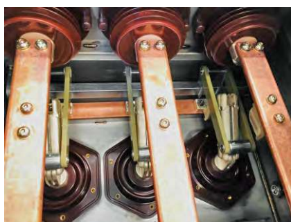
Трехпозиционный выключатель
